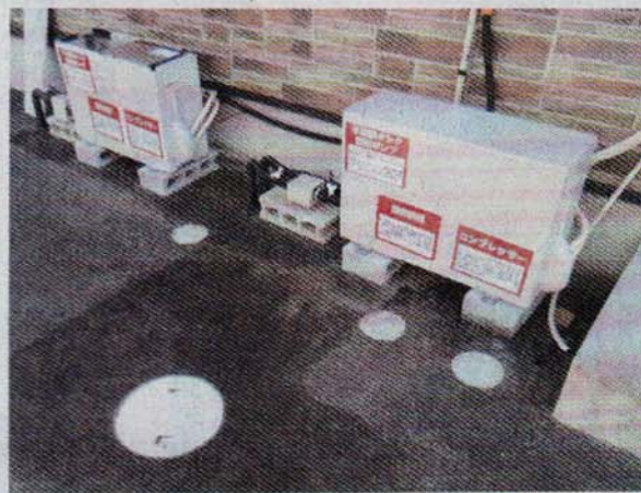
LIXIL住研の地中熱利用住宅の採熱孔(手前)とヒートポンプ機器
